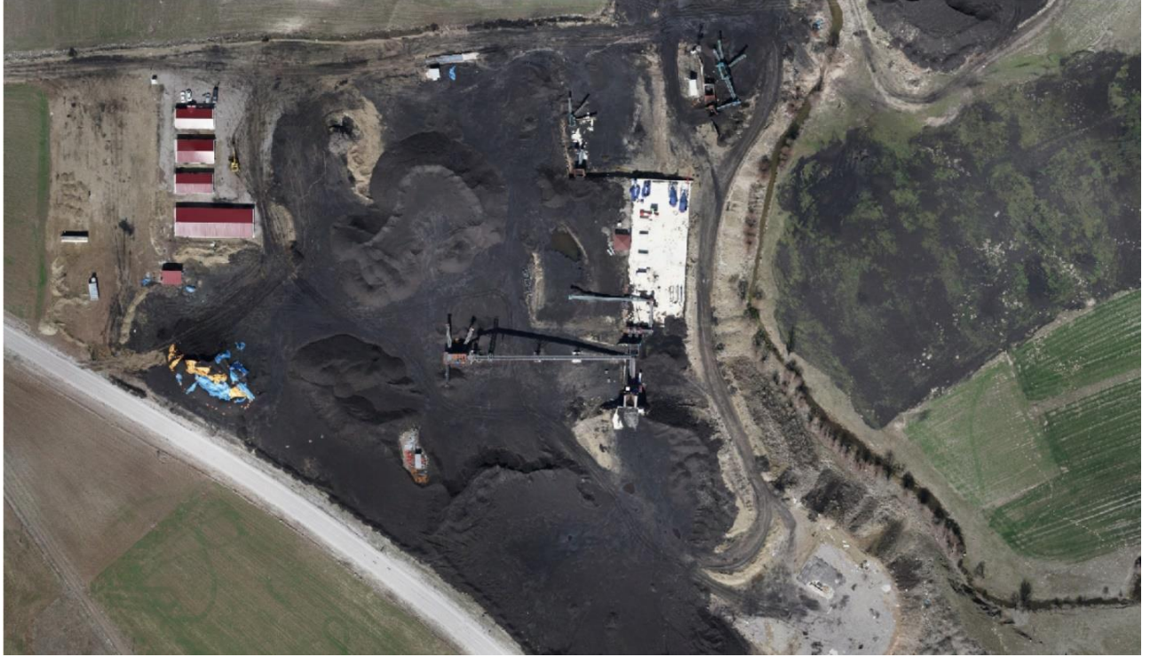
Resim 25: Şantiye Alanı Uydu Görüntüsü
