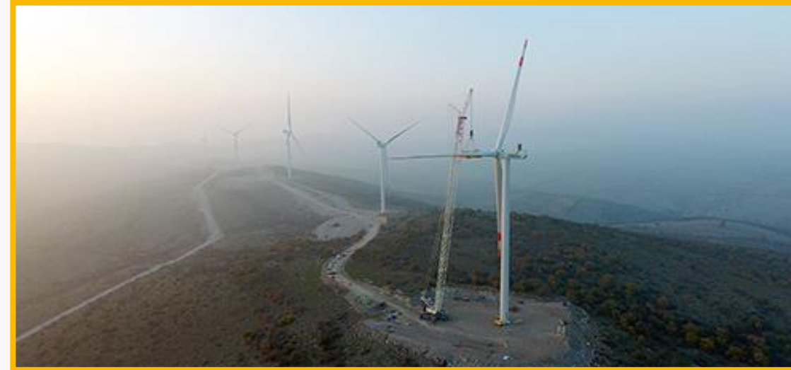
VESTAS - Balıkesir Rüzgar Türbin Montajı
